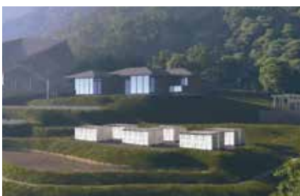
ZONE ISOLÉE HORS RÉSEAU
